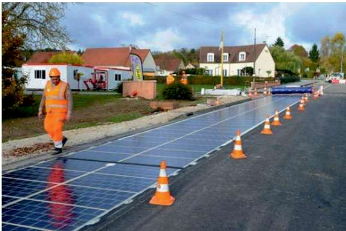
Рис. 6. Будівництво автобанів з сонячних батарей
