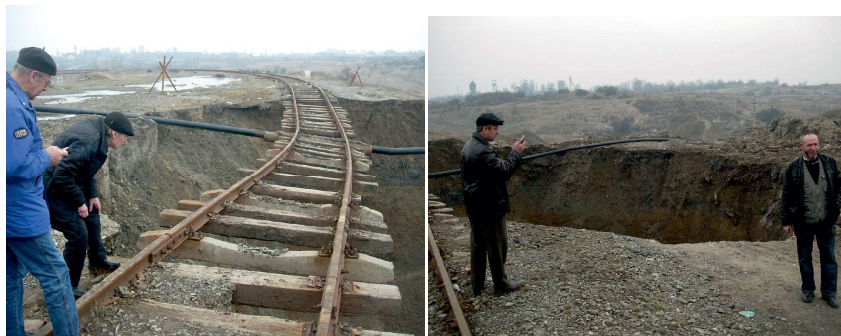
Рис. 10. Карстові провалля на земній поверхні Солотвинського рудника
