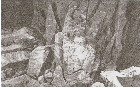
Рис. 13. Зруйнований міжкамерний стовп через п'ять років після видобутку руди. Північне сільвінітове поле Калуського рудника
