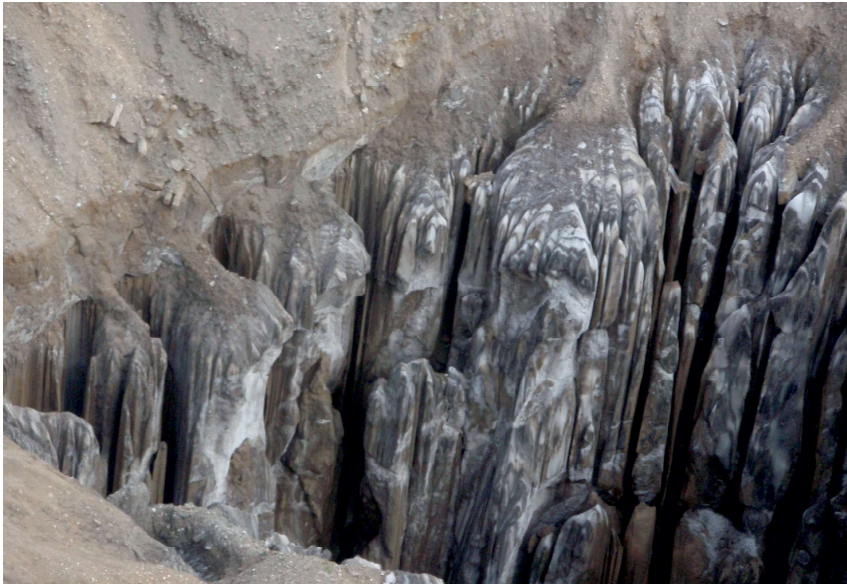
Рис. 7. Карстові утворення в покрівлі кам'яної солі над камерами першого горизонту шахти № 8 Солотвинського рудника
