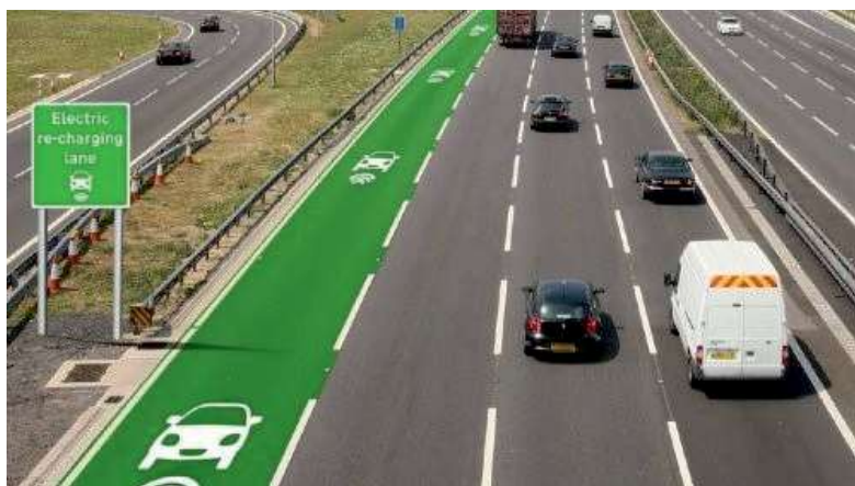
Рис. 5. Спеціальна смуга для підзарядки електромобілів під час руху
