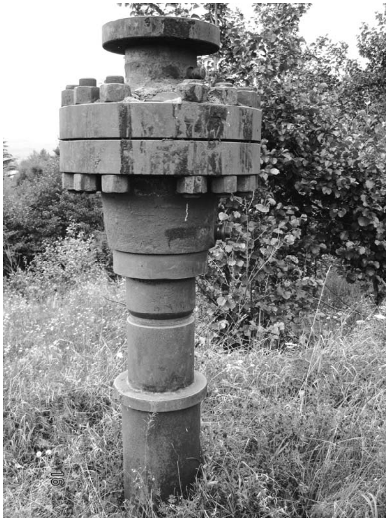
Рис. 22. Експлуатаційна колона висотою 1,5 м. Свердловина Завода-1. Берегова скиба. Скибовий покрив. Лівий борт р. Стрий. За 1,5 км від гирла р. Опір, на північ від смт Верхне Синьовидне.
