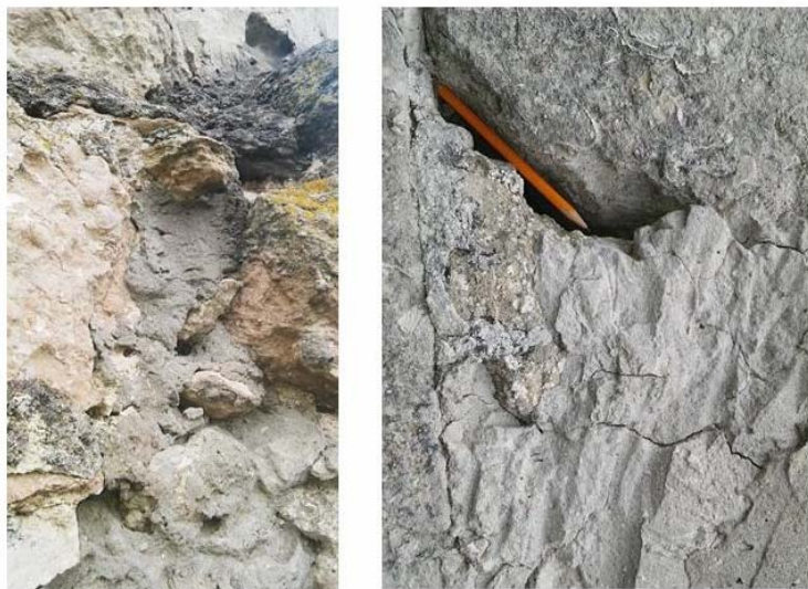
Рис. 6. Стан швів між кам'яними блоками у кладці стін вежі.
